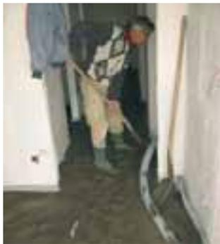
Réaliser une chape de propreté afin de recouvrir les tuyaux et autres gaines. Si la réalisation d'une préchape est impossible, la dalle béton devra être plane et soigneusement brossée. Aux croisements de tubes, il sera prévu des solins ou doucines en sable/ciment. Dans tous les cas, les canalisations verticales, chauffage et sanitaire, seront soigneusement isolées du plancher qu'elles traversent, par des manchons confectionnés sur place avec l'Insulit.
